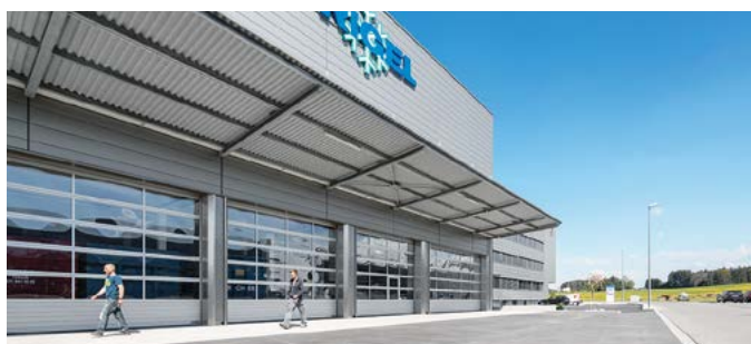
Die hohe Qualität der Zumtobel Leuchten zeigt sich in allen Bereichen – auch bei feuchter oder kühler Umgebung.
