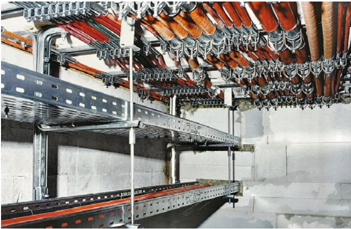
Versuchsaufbau vor der Prüfung
