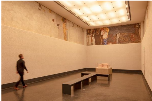
Bild 2: Im Rahmen der Generalsanierung erarbeitete Zumtobel eine Sonderlichtlösung TECTON slim tunableWhite, die mit ihren LED-Leuchten ein angenehmes, gleichmäßiges Licht liefert – mit z.B. 3000 K (a), 4000 K (b), 6000 K (c). / Courtesy of Ed Ruscha und Gagosian
