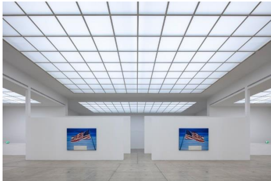
Bild 2: Im Rahmen der Generalsanierung erarbeitete Zumtobel eine Sonderlichtlösung TECTON slim tunableWhite, die mit ihren LED-Leuchten ein angenehmes, gleichmäßiges Licht liefert – mit z.B. 3000 K (a), 4000 K (b), 6000 K (c). / Courtesy of Ed Ruscha und Gagosian
