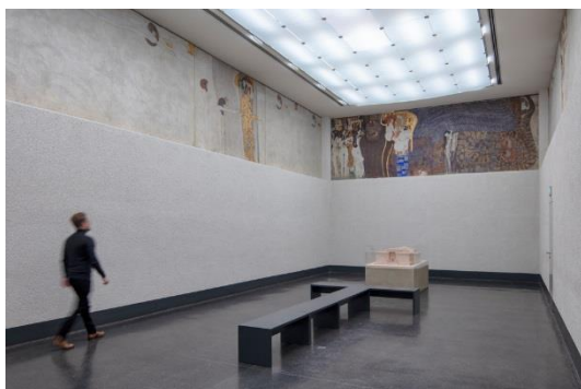
Bild 3: Während die TECTON slim tunableWhite LED-Leuchten eine Lichtdecke in 3000 K (a), 4000 K (b), 6000 K (c) illuminieren, tauchen SUPERSYSTEM II LED-Strahler den Beethovenfries erstmals großflächig in direktes Licht, um so eine fast dreidimensionale Wirkung zu erzeugen.
